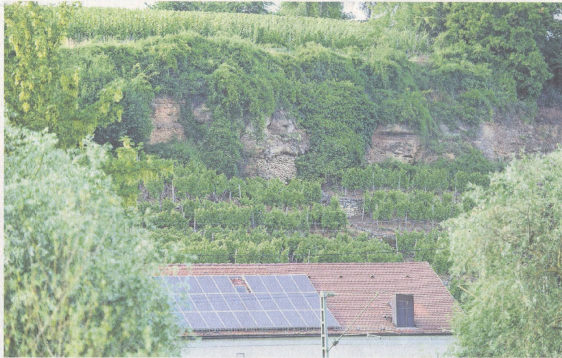
Immer wieder kommt es am Nagelfluhfelsen in Klingenberg zu Steinschlag. Menschen, die im darunter liegenden Weinberg arbeiten, sind dadurch gefährdet. Jetzt werden Lösungen gesucht, wie das Naturdenkmal saniert werden kann. Foto: Martin Barzant
